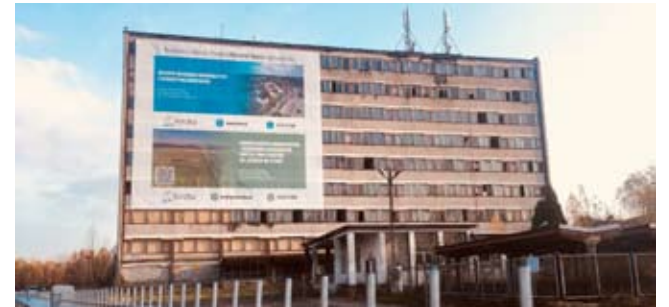
Str. 9 | Prace przy FUM-ie
